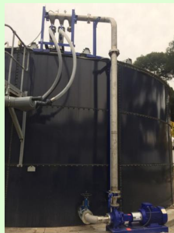
Instalación superior del clúster
