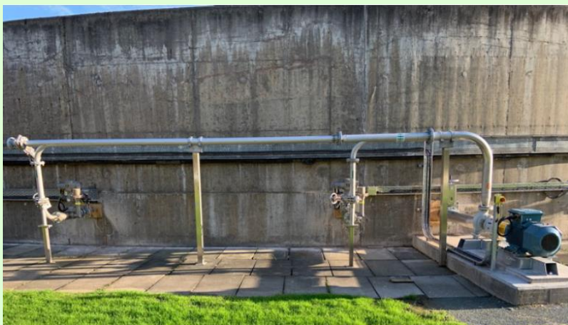
Instalación inferior del JetBlower con pasamuro
