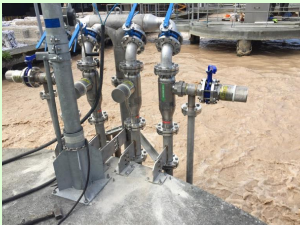
Clúster de 3 JetBlower con bomba sumergible
